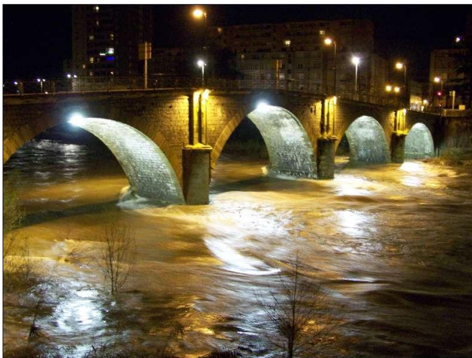
Le Gardon d'Alès (à Alès, pont de Rochebelle) le 23 décembre au soir (photo Davidgard )
