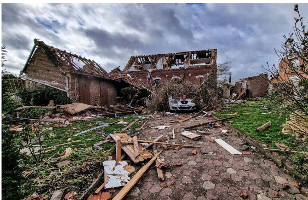
Dégâts provoqués par la tornade près de Bihucourt (62). Photo 20 minutes
