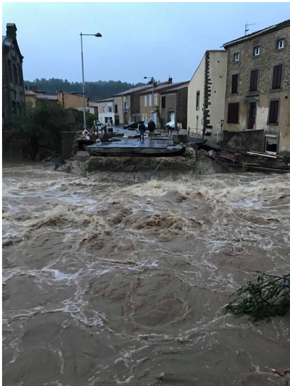
Le Trapel emporte le pont de la route de Mazamet - Photo l'Indépendant.
