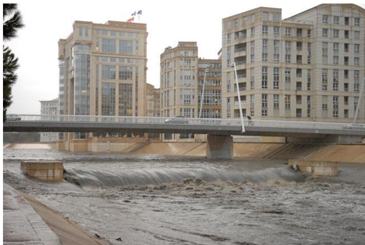
Le Lez en crue dans le quartier d'Antigone à Montpellier le 20 octobre (Photo Midi Libre ).
