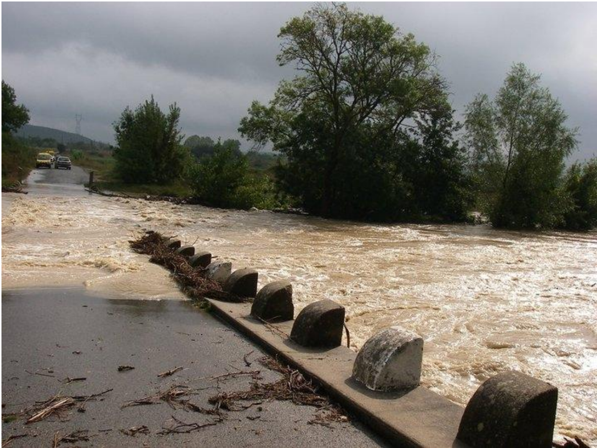
Le Vidourle le 8 au matin au pont de Lecques , près de Sommières, après les 322 m de Conqueyrac. Notons qu'il s'agit d'un pont submersible souvent noyé par la moindre Vidourlade. Photo f4tnk .
